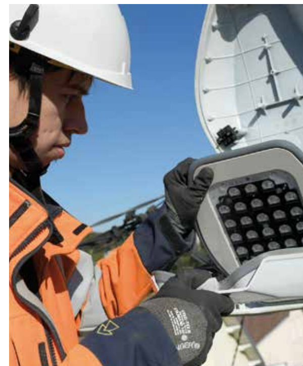
▲ Éclairage public : remplacement des lampes par des leds.
